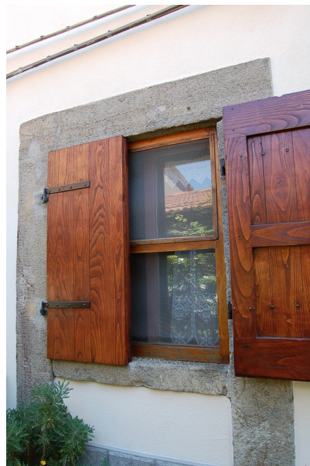
Esempio di finestra con persiane e con scuri esterni nel borgo di Arcidosso
