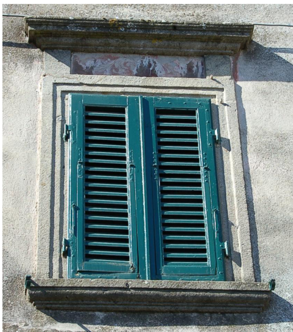
Esempio di finestra con persiane e con scuri esterni nel borgo di Arcidosso
