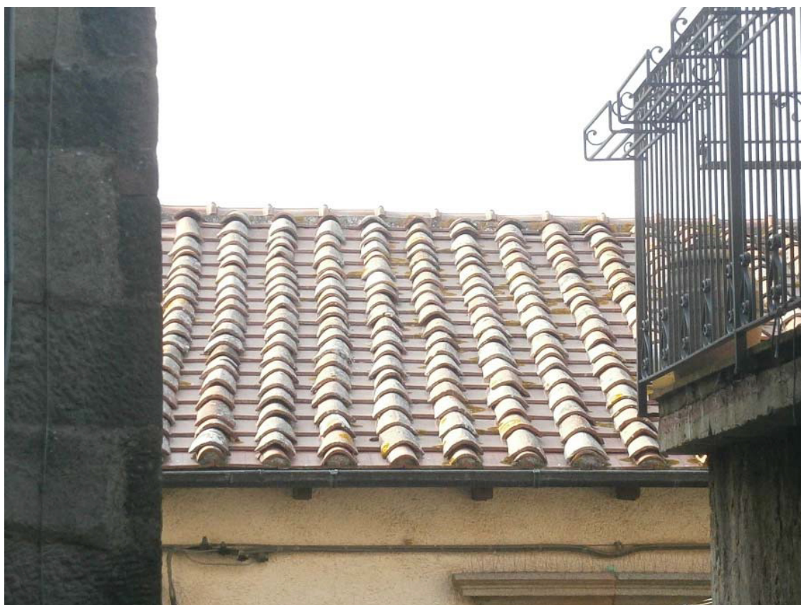
Esempi di manto di copertura in laterizio a “coppi ed embrici”
