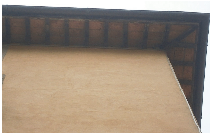
Travetti in legno e mensole costituite da mezzane piene in cotto
