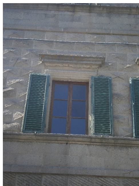
Finestra in castagno naturale e persiane in legno laccate colore verde originali.
