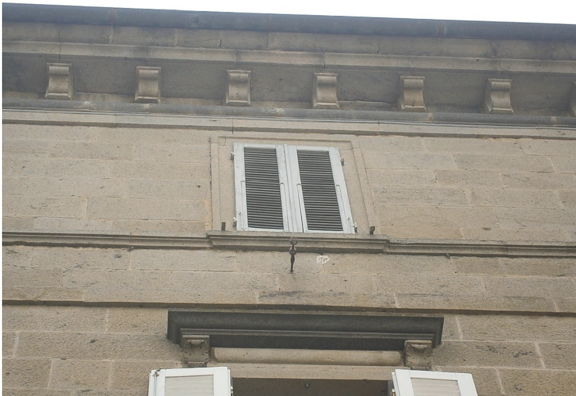
Cornicioni di gronda in materiale lapideo di pietra locale
