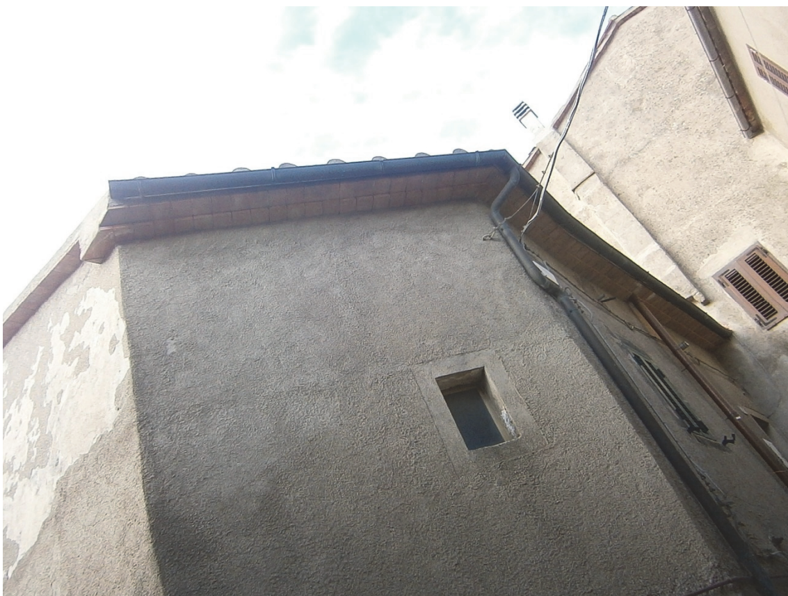
Aggetti in mezzane di cotto sovrapposte a due o più livelli.
